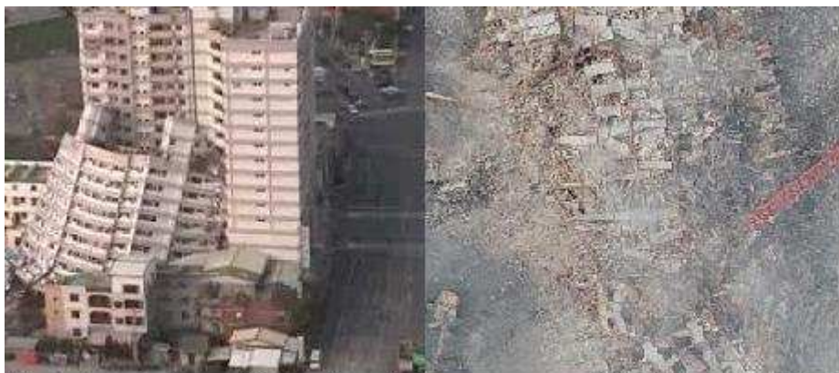
Compárese el primer edificio, colapsado por causas naturales, y el segundo, el WTC 7 que toda su estructura se ha desintegrado y las columnas están partidas en sus juntas
