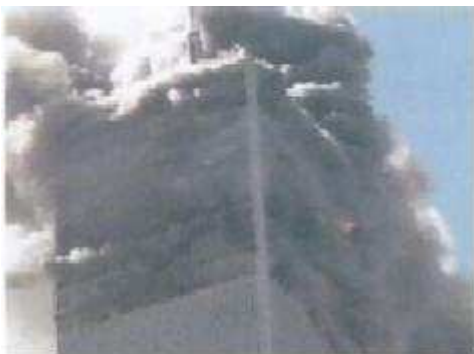
WTC 1 dos segundos antes del colapso, nótese el humo negro y el poco fuego visible
