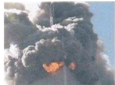
WTC 1 momento del colapso, véase la fuerte presión la cual impulsa las llamas y el humo al exterior
