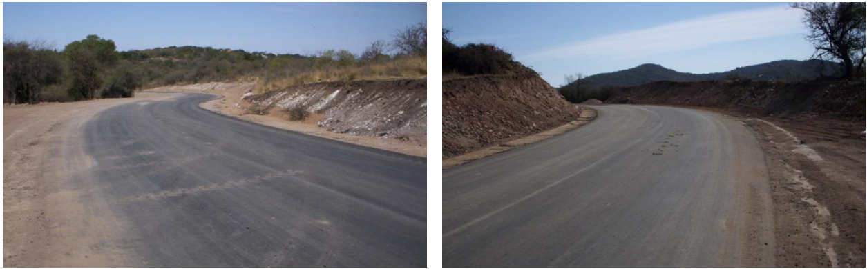
Tramos de la obra ya pavimentado. Se observan los cortes sobre la topografía.
